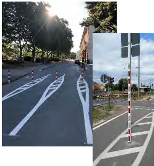
Abbildung: Warnmarkierung Sperrpfosten und reflektierender Mast
