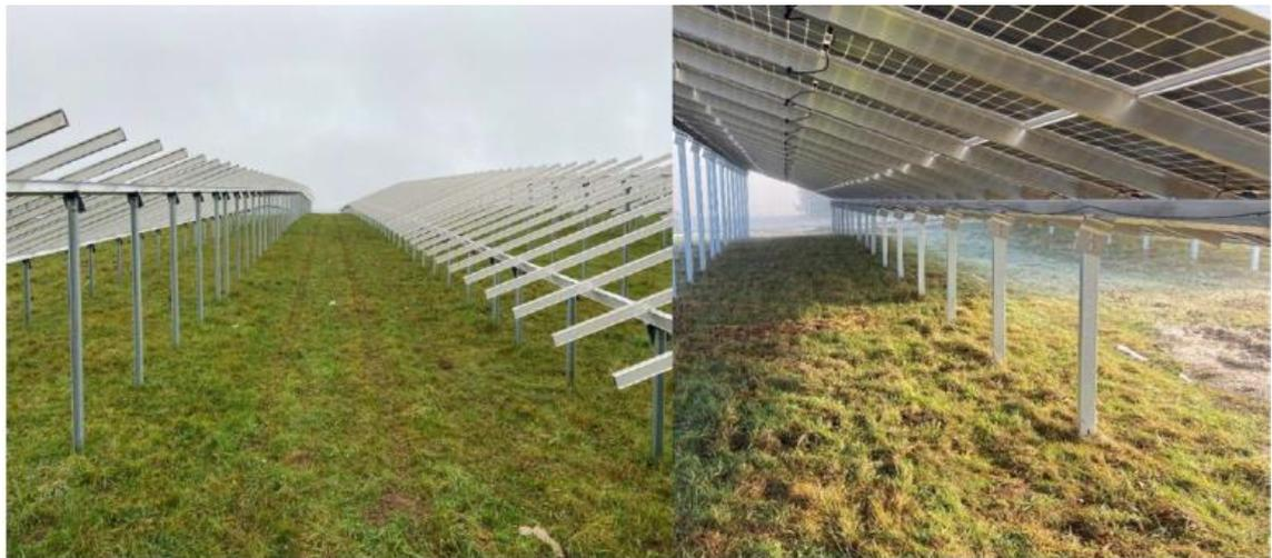
Abb. 9: Beispielfoto, Unterkonstruktion und bifaciale Module, die lichtdurchlässig sind (Quelle: Wircon GmbH)
