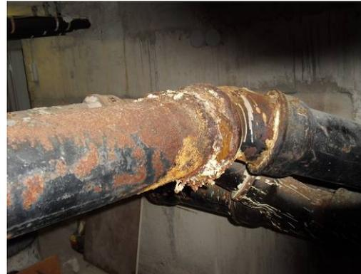
Starke Korrosionsschäden des Leitungssystems im Untergeschoss
