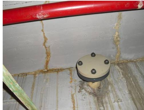
**Deutliche Risse und stark vorangeschrittene Betonkorrosion. Eine kurzfristige Schließung des Bades auf Grund der Standsicherheit der Beckenwände ist zu erwarten.**
