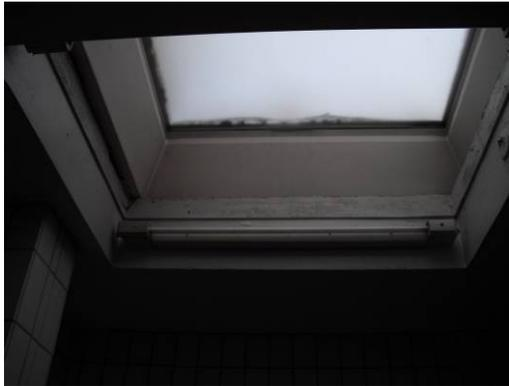
**Lichtkuppeln mit deutlichen Alterungsspuren sowie Undichtigkeiten**
