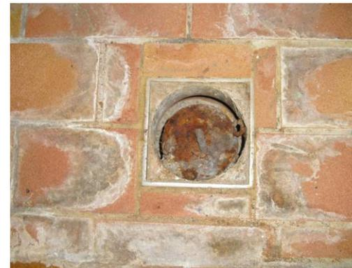
Die Bodenabläufe weisen starke Schäden durch Korrosion auf und ist daher mittelfristig nicht mehr funktionstüchtig.
