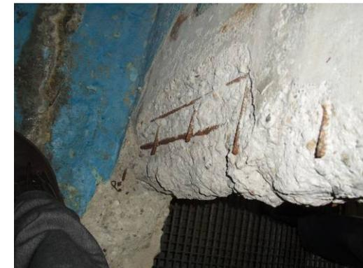
Das gesamte Bauwerk weist Spuren von Betonkorrosion auf
