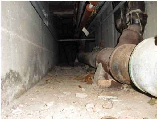
**Leitungssystem der technischen Anlagen mit deutlichen Korrosionsschäden**
