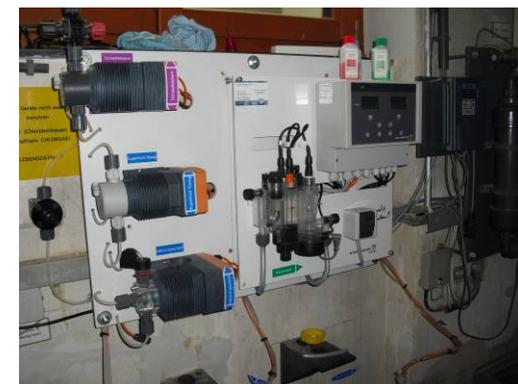
**Chemische Beckenwasser-aufbereitung neueren Baujahrs. Auf Grund der Lebensdauer der Anlage ist langfristig mit einem Erneuerungsbedarf zu rechnen.**
