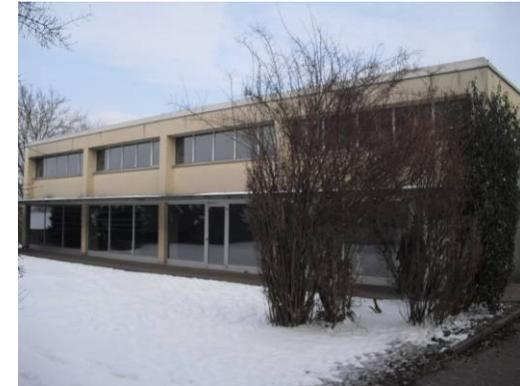
**Gebäudehülle mit geringer Wärmedämmung und Alterungsspuren. Gesetzliche Bestimmungen zwingen zur Sanierung gemäß Energieeinsparverordnung (ENEV)**
