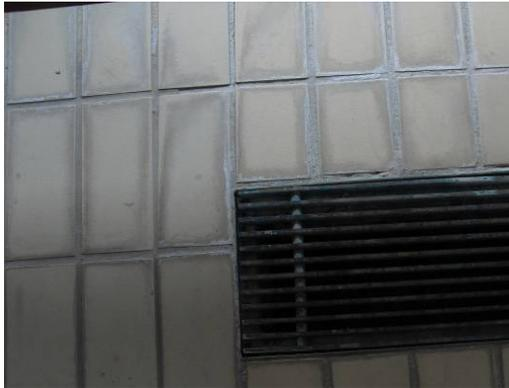
**Fliesenbelag der Schwimmhalle und der Umkleide mit starken Ausblühungen, fehlende Abdichtung zum UG**
