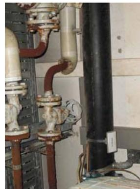
Die Badewasseraufbereitungsanlage weist Alterungsspuren auf und ist mittelfristig zu erneuern
