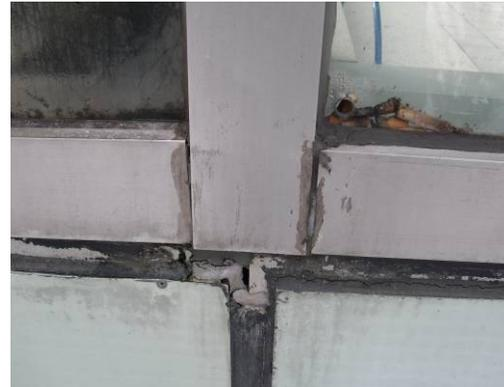
Die Alu-Glasfassade weist deutliche Alterungsspuren auf, Die Verglasung weist keine Isolierwirkung durch Bohrungen auf. Die Fugen sind porös und nicht mehr dicht.
