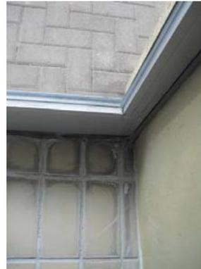
**Undichte Fensterkonstruktionen mit starken Alterungsspuren**
