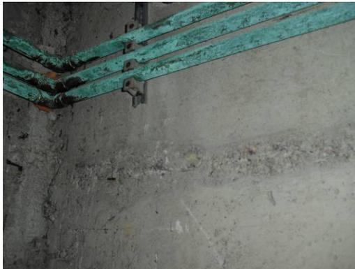
Das Leitungssystem der Badewassertechnik, des Brauchwassers und der Heizung weist starke Alterungsspuren auf
