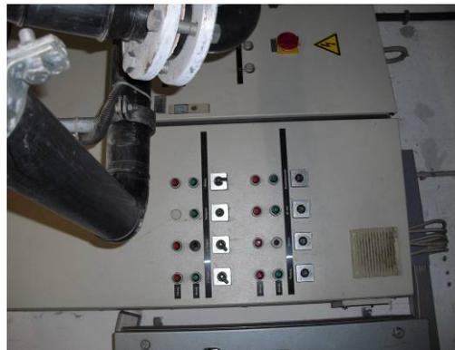
**Veraltete Beckenwasseraufbereitungsanlage am Ende seiner technischen Lebensdauer**
