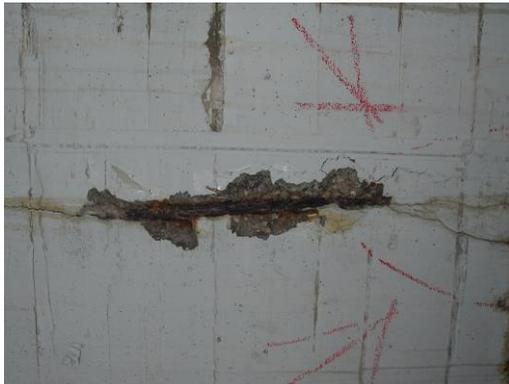
**Deutliche Risse und stark vorangeschrittene Betonkorrosion im gesamten Untergeschoss. Kurzfristig wird die Standsicherheit nicht zu gewährleisten sein.**
