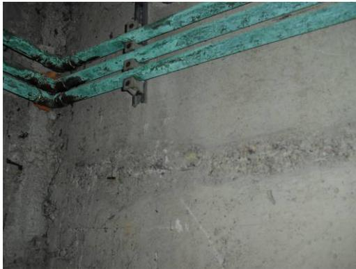
Das Leitungssystem der Badwassertechnik, des Brauchwassers und der Heizung weist starke Alterungsspuren auf
