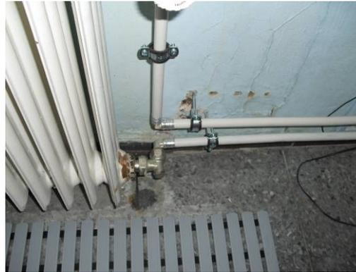
**Korrosion an den Heizkörpern und den Rohrleitungen, teilweise bereits mit Undichtigkeiten**
