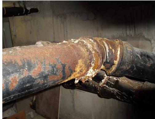
Starke Korrosionsschäden des Leitungssystems im Untergeschoss
