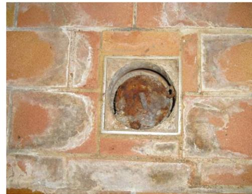
Die Bodenabläufe weisen starke Schäden durch Korrosion auf und daher mittelfristig nicht mehr funktionstüchtig.
