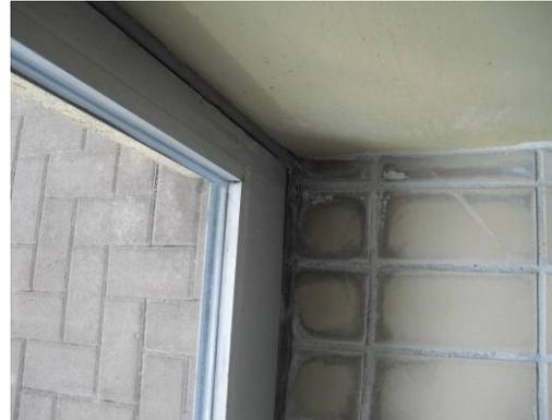
**Undichte Fensterkonstruktionen mit starken Alterungsspuren**
