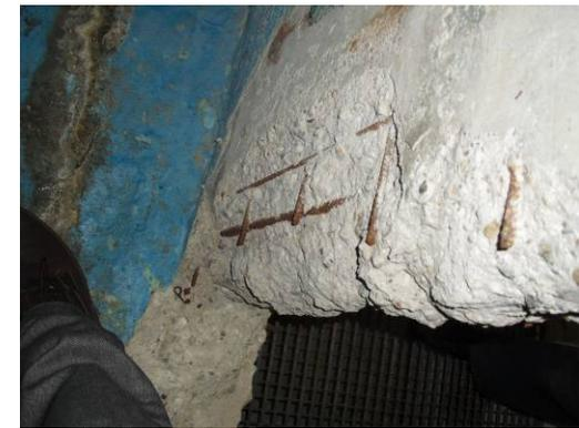
Das gesamte Bauwerk weist Spuren auf Betonkorrosion auf
