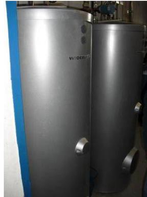
**Warmwasserspeicher neueren Baujahrs.**
