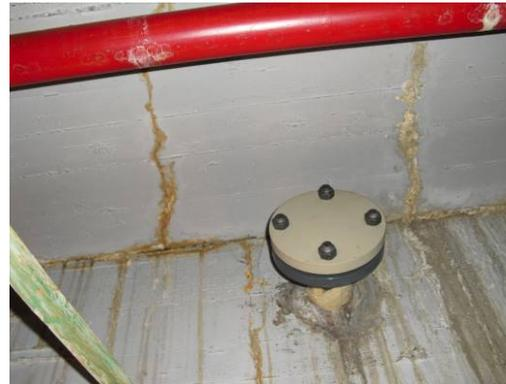
**Deutliche Risse und stark vorangeschrittene Betonkorrosion. Eine kurzfristige Schließung des Bades auf Grund der Standsicherheit der Beckenwände ist zu erwarten.**
