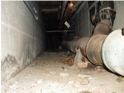
**Leitungssystem der technischen Anlagen mit deutlichen Korrosionsschäden**
