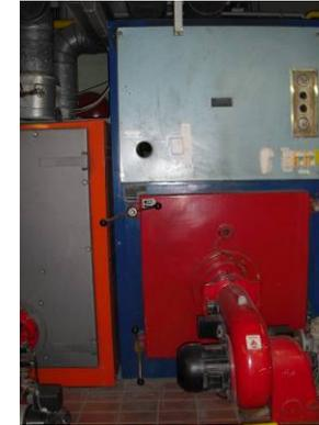
Kesselanlage mit deutlichen Alterungsspuren am Ende der technischen Lebensdauer mit schlechtem Wirkungsgrad.
