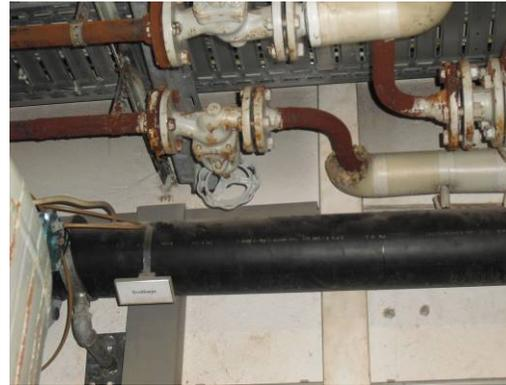
Die Badewasseraufbereitungsanlage weist Alterungsspuren auf und ist mittelfristig zu erneuern
