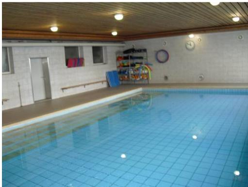
**Der Fliesenbelag weist deutliche Alterungsspuren durch Hohlräume. Mittelfristig ist daher das Becken neu zu fliesen. Der Deckenbelag und die Beleuchtung entspricht nicht dem gesetzlichen Anforderungen.**
