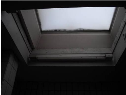
**Lichtkuppeln mit deutlichen Alterungsspuren sowie Undichtigkeiten**
