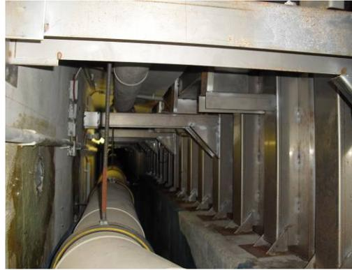
Beckenumgang im UG der Schwimmhalle: Undichtigkeiten der Abdichtung zur Schwimmhalle, Korrosion durch chlorhaltiges Milieu
